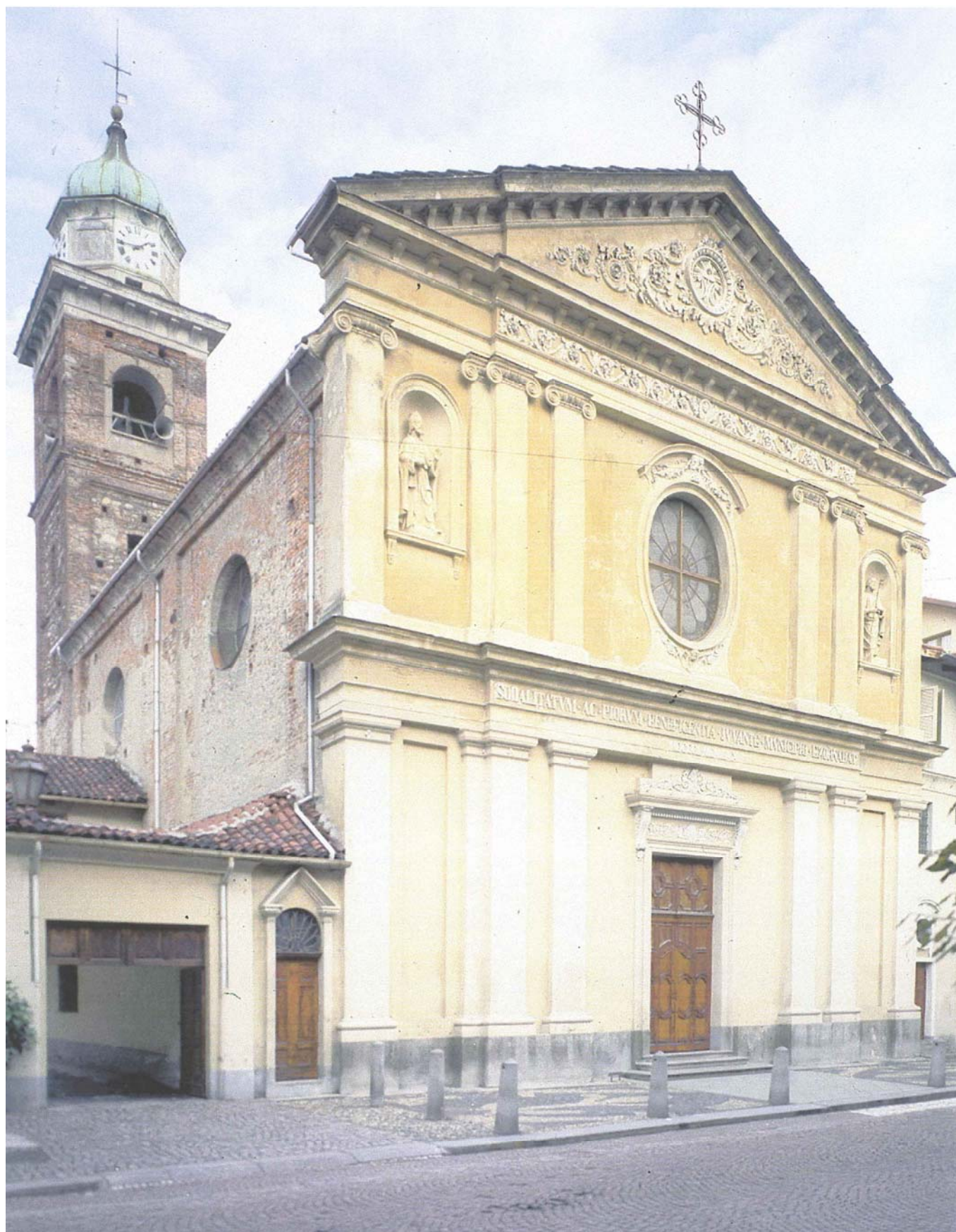
Chiesa di San Giuseppe prima del restauro, vista su via Vittorio Emanuele.
