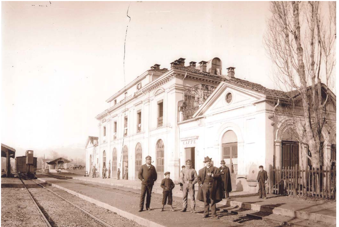
Stazione ferroviaria, lato binari.
