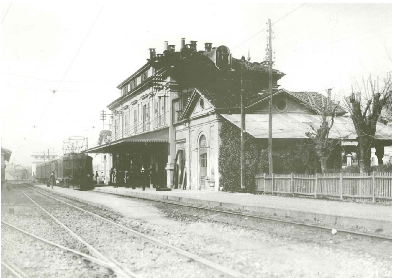
Stazione ferroviaria, lato binari.
