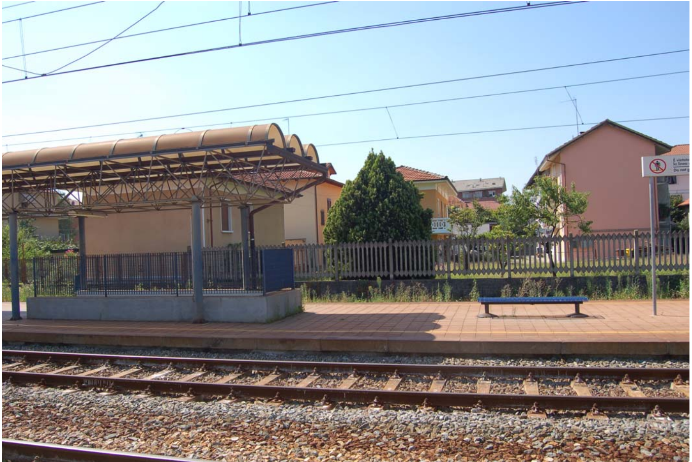
Stazione ferroviaria oggi, lato binari.
