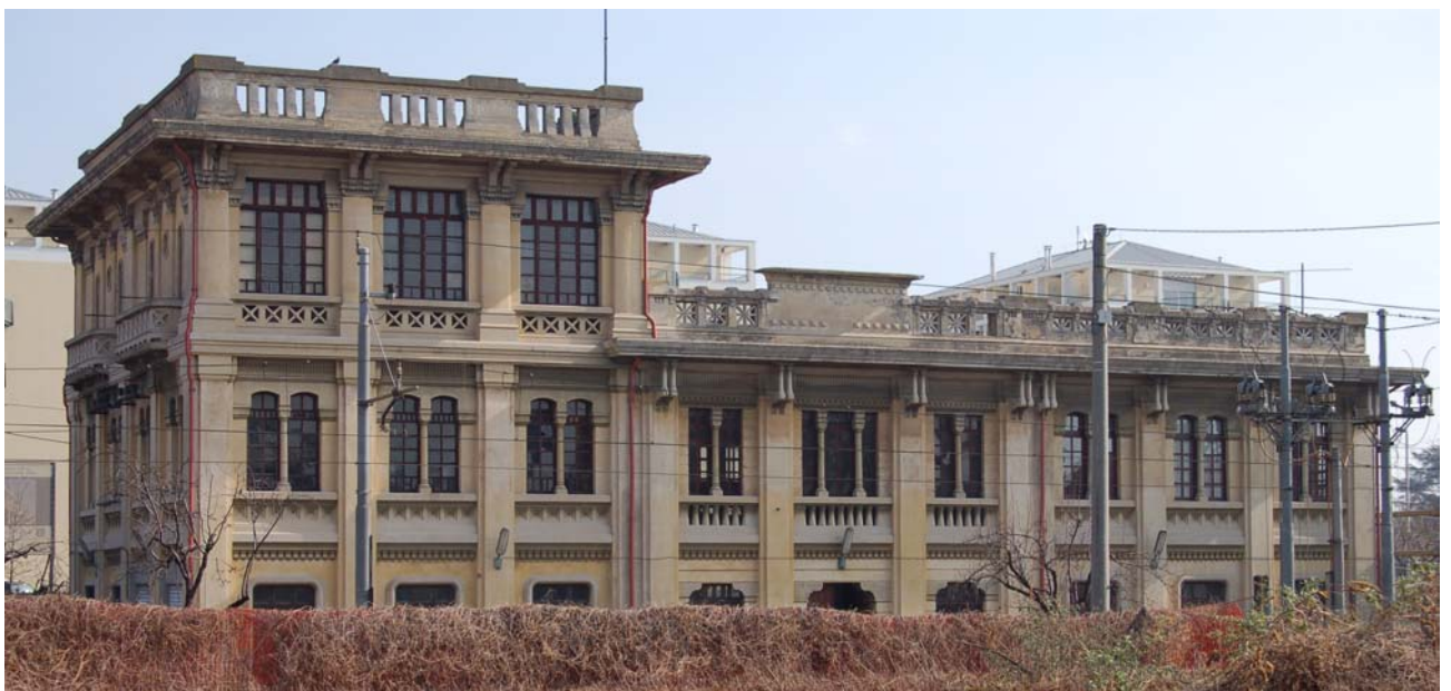
Centrale elettrica, vista da via Monte Grappa.
