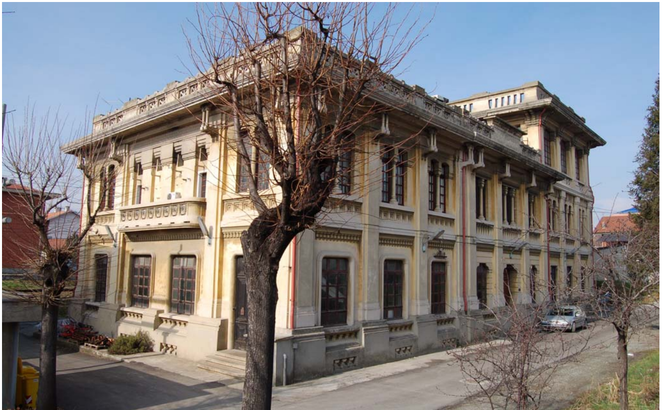
Centrale elettrica, vista su via Mazzini.
