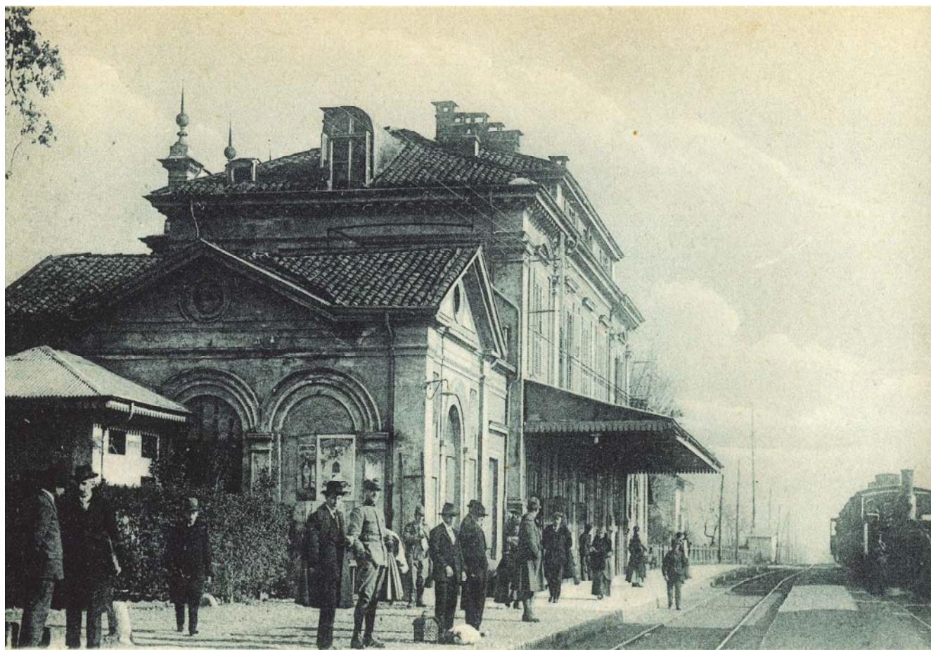
Stazione ferroviaria, lato binari.
