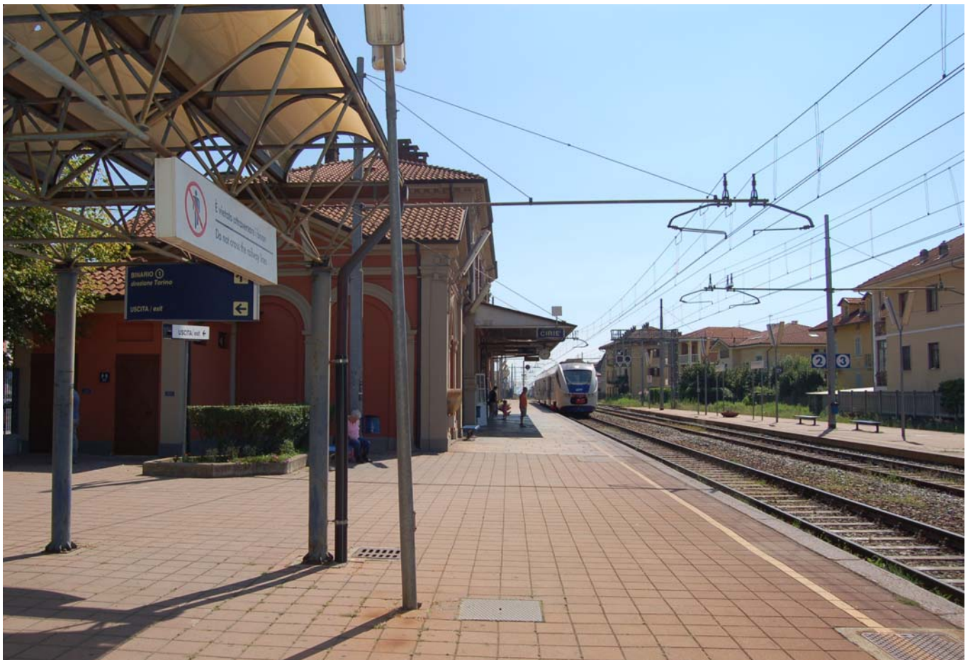
Stazione ferroviaria oggi, lato binari.
