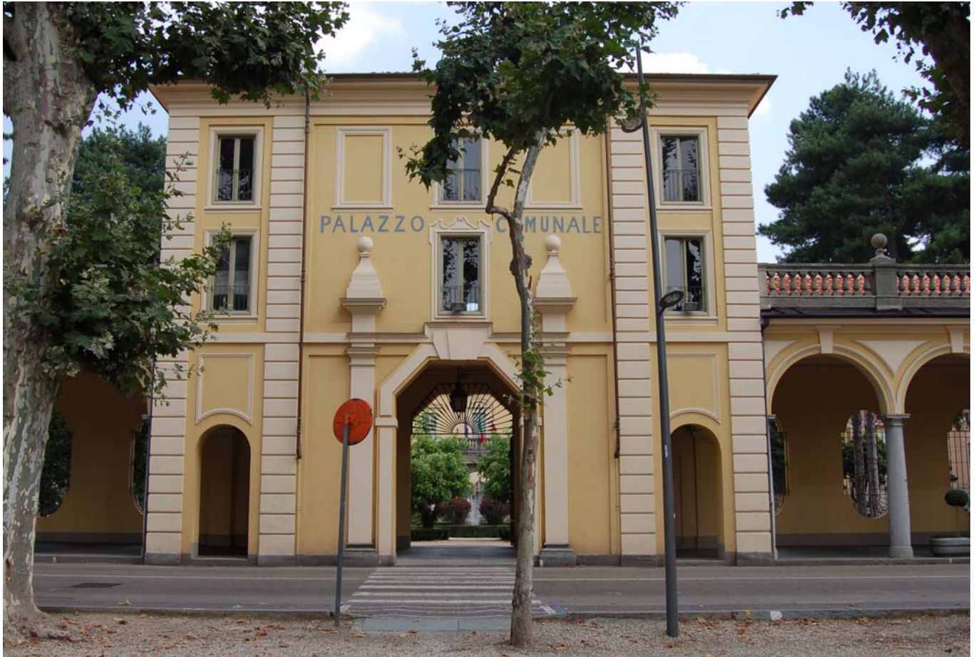
Palazzo D'Oria e giardino, ingresso su Corso Martiri della Libertà.
