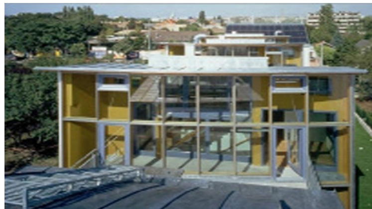
Esempio di serra ad accumulo - Vienna
