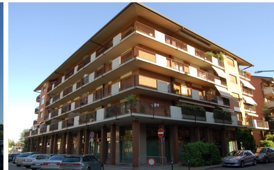
Tipologia condominiale tipica di via Rossetti.
