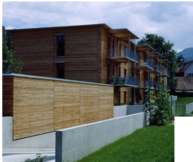
Abitazioni con sistema di raffrescamento
