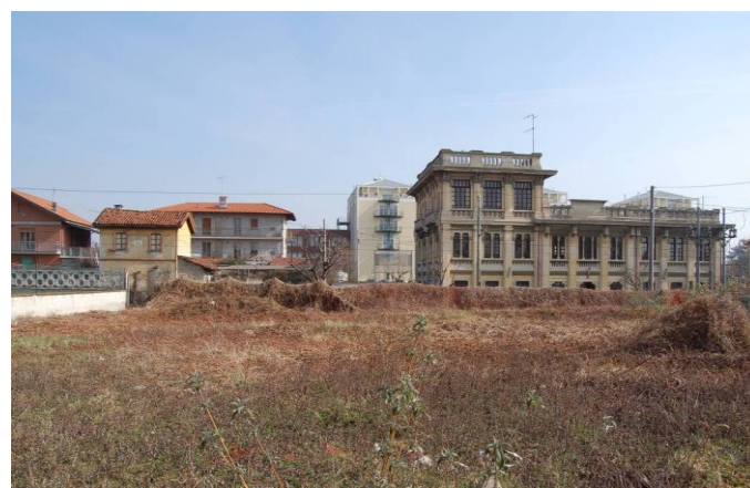
La centrale elettrica vista da sud.
