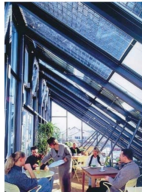
Interno di una serra – fotovoltaico trasparente
