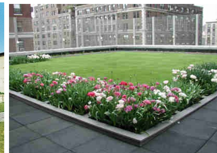
Esempio di copertura verde
