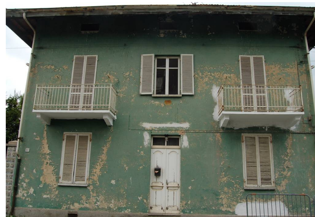
Edifici in via Montegrappa.
