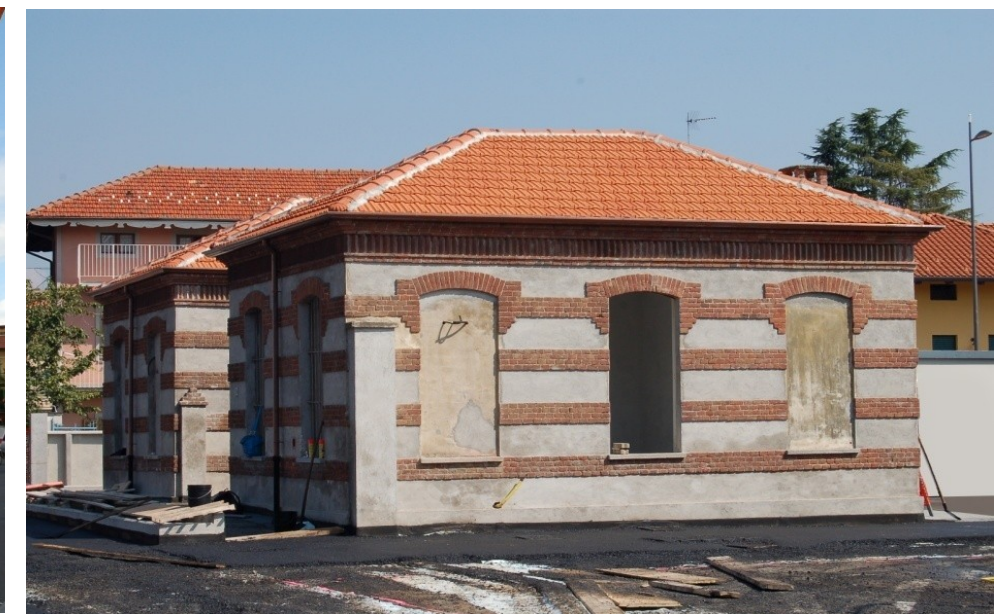
Edifici in prossimità dell'antico Mattatoio demolito.
