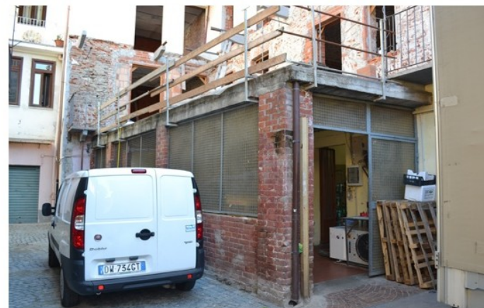
Interno Via Matteotti
