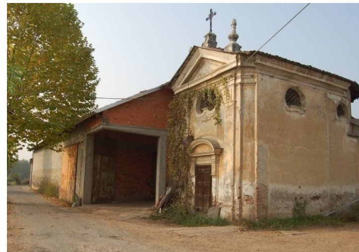
Cascina Cascinetto, cappella e ingresso.
