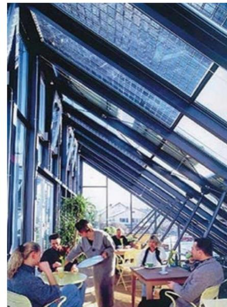
Interno di una serra – fotovoltaico trasparente
